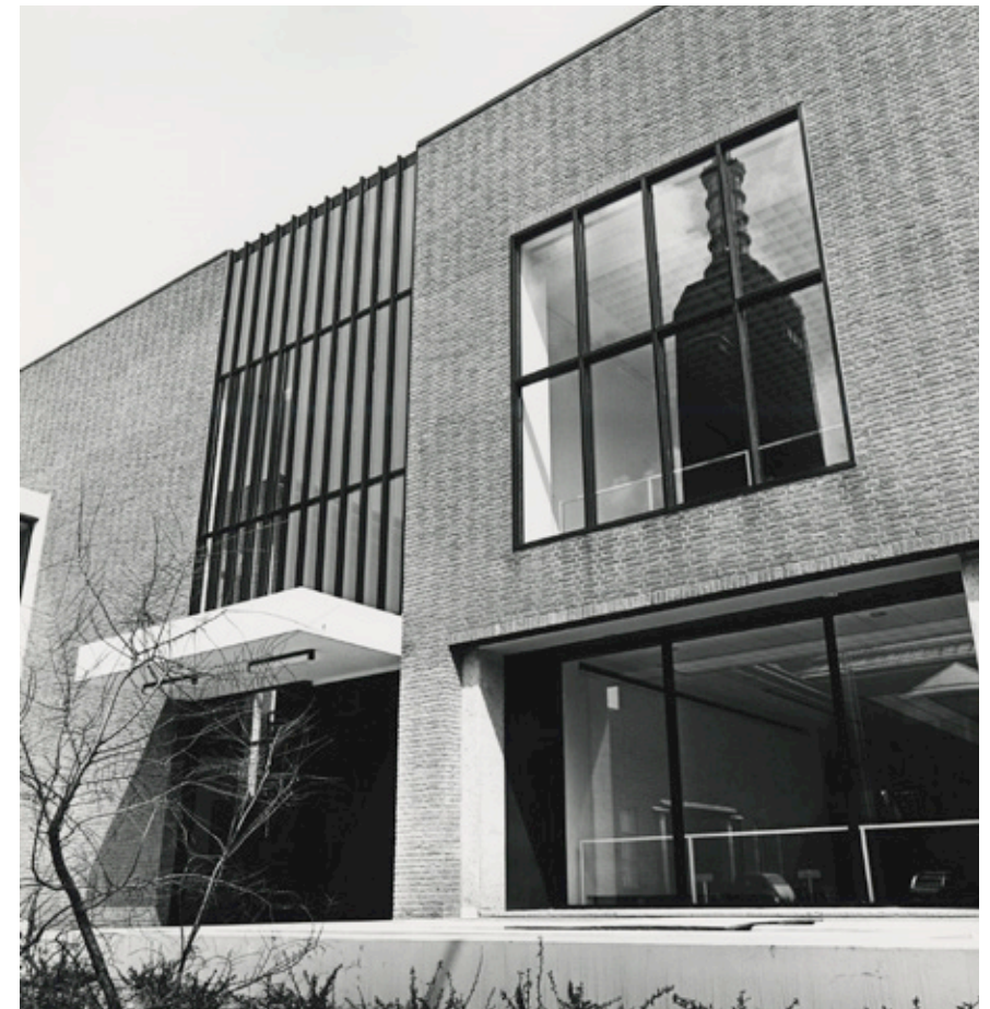
Afb. 70 Exterieur van de Bodonvleugel, westgevel met de grote vensters die zijn dichtgemaakt tijdens de verbouwing van 2003; deze gevel grensde aan de binnenplaats waar de architectuur van Bodon verbonden is met de oudbouw van Van der Steur
